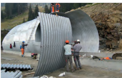
Formontering av veggplater
