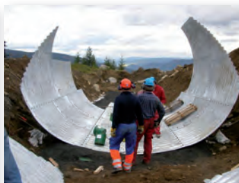
Montering av sideplater
