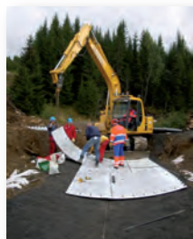
Montering av bunn- og hjørneplater
