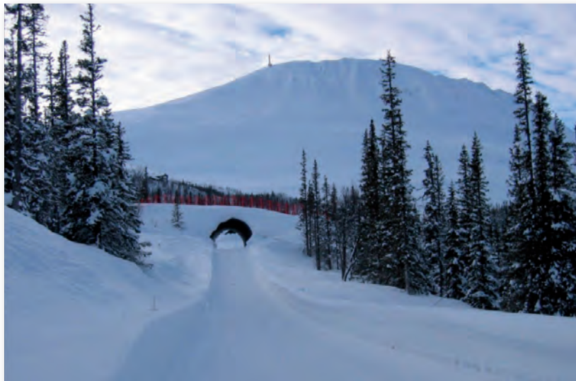
Ferdig montert MP 200 hvelvbue ved Gaustadtoppen
