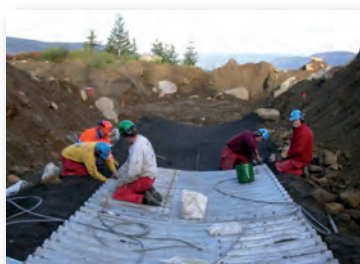
Oppstart montering av bunnplater
