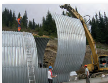
Innheising av veggplater
