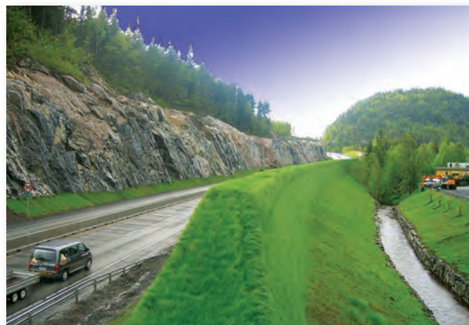
5 m høy støyvoll bygget av jordmasser armert med TeleGrid® og med front av torvblokker.
