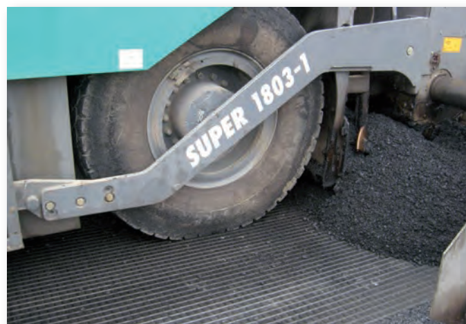
TeleRoad® asfaltarmering ligger stabilt og påvirker ikke utleggingsprosessen.
