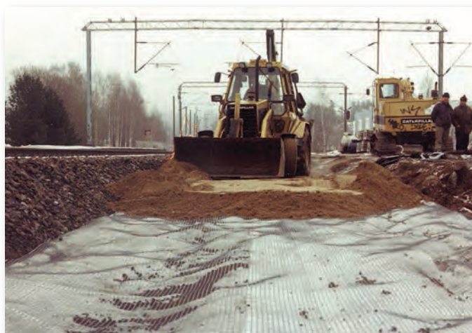
Utlegging av bærelagsmasser på TeleGrid® jordarmeringsnett.
