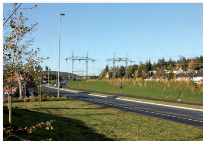
Støyvoll langs motorvei, bygget med TeleGrid® jordarmering og torvblokker.
