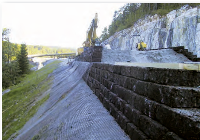
Støttekonstruksjon med TeleGrid® jordarmering og front av torvblokker.
