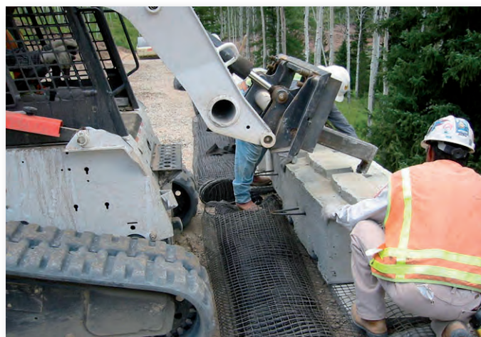
Bygging av støttekonstruksjon med TeleGrid® som jordarmering, og front av betongblokker.
