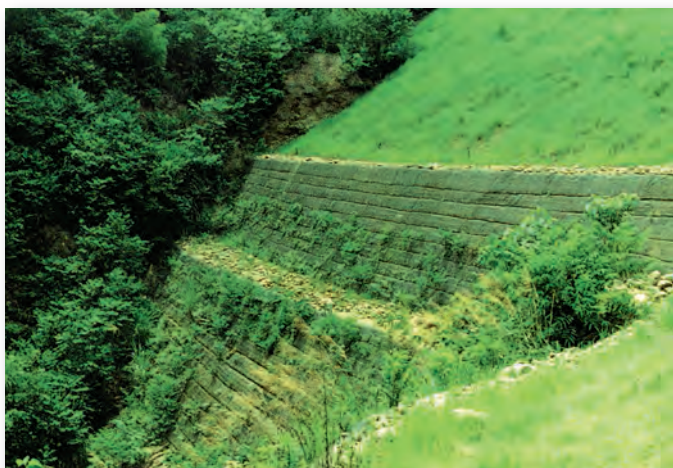
Høy oppstrammet skråning i terrassert utførelse, bygget med TeleGrid® jordarmering.
