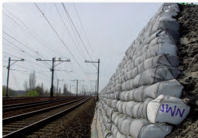
Støttekonstruksjon med TeleGrid® jordarmering og front av TeleBag® fylt med grus.
