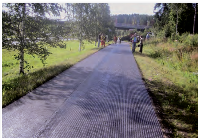
TeleRoad® asfaltarmering lagt ut og klebet for utlegging av asfaltmassen.
