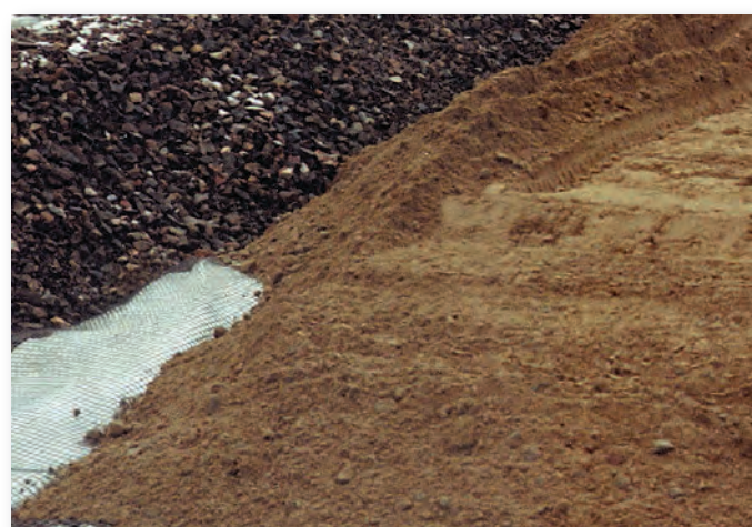
TeleGrid® som forsterkning under jernbane.
