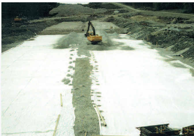
Motorveibygging med bruk av TeleVev® som separasjon og armering av forsterkningslag.
