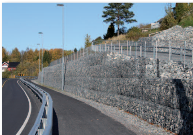
Gabioner med TeleVev® som armering i bakfylling
