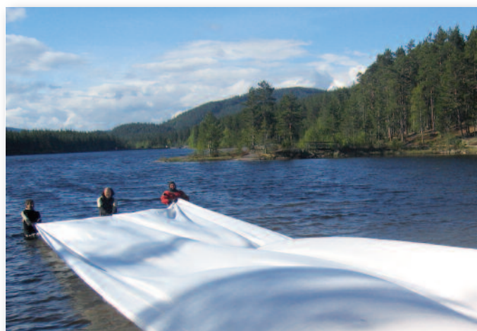
TeleEnviro® som separasjon og forsterkning på badestrand
