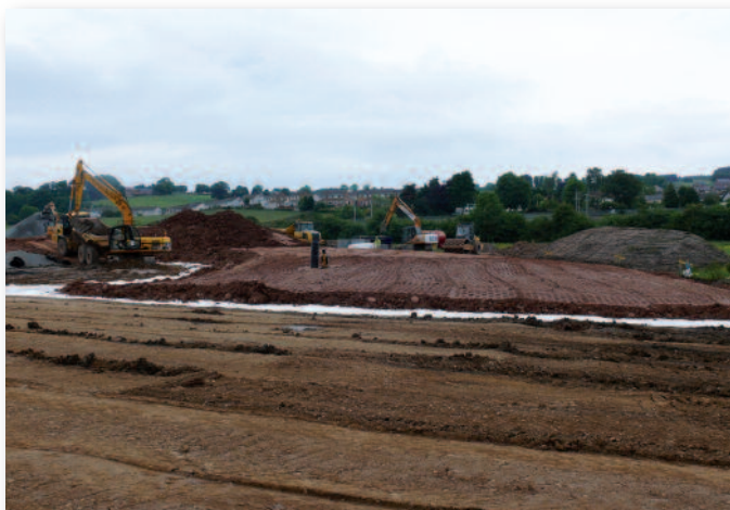
TeleVev® kan legges ut med overlapping i skjøtene, eller om ønskelig sys sammen til store flak.
