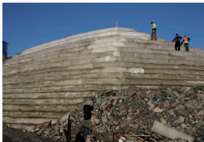
Skråning i ca. 45 graders helning bygget på av drenerende masser armert med TeleVev®.
