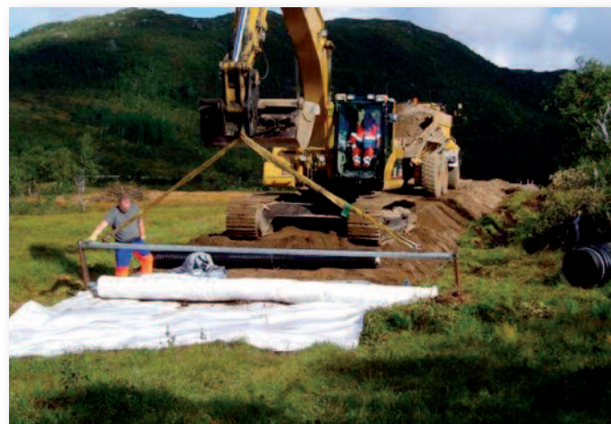
TeleVev® benyttet i anleggsvei ved bygging av Lofast forbindelsen
