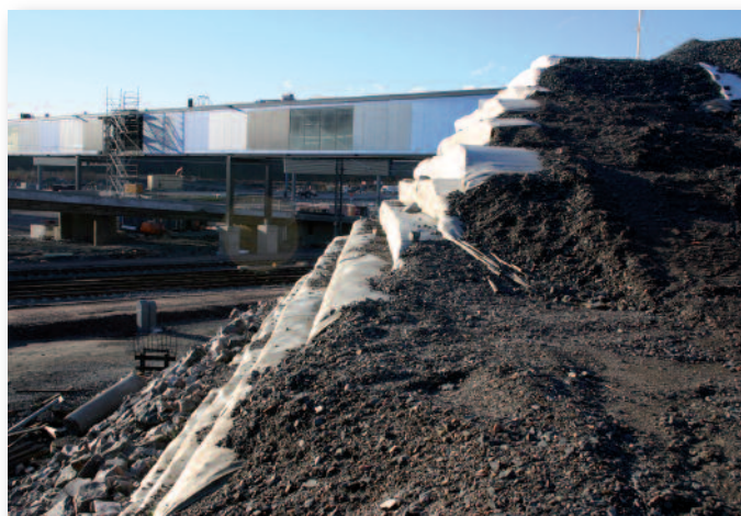
Skråning i ca. 45 graders helning bygget på av drenerende masser armert med TeleVev®.
