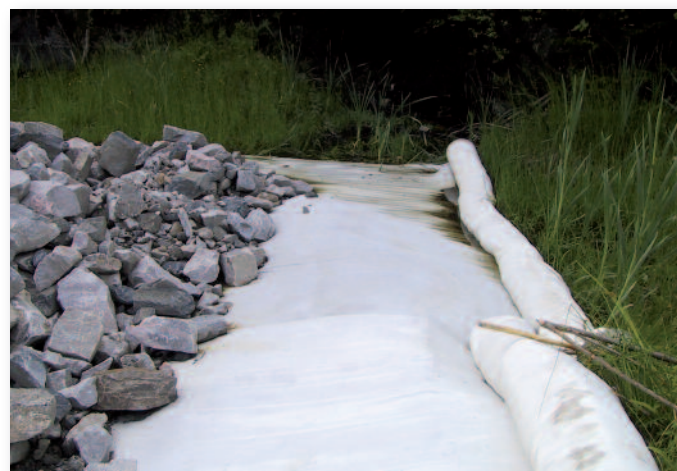
Etter at TeleVev® er rullet ut på grunnen kan fyllmassene legges ut uten ytterligere forberedelser.
