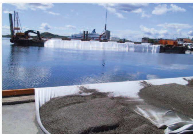
TeleEnviro® til armering og grunnforsterkning ved bygging av nye opera i Oslo
