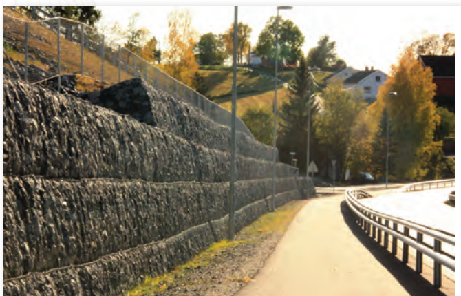
Gabioner i støttekonstruksjon
