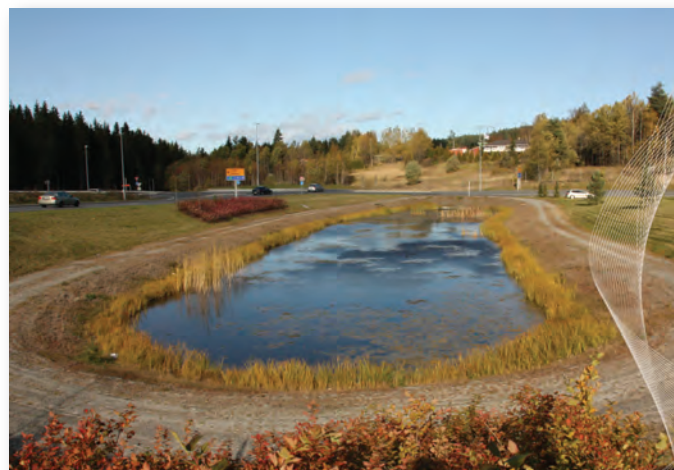
Damprosjektet ferdig utført
