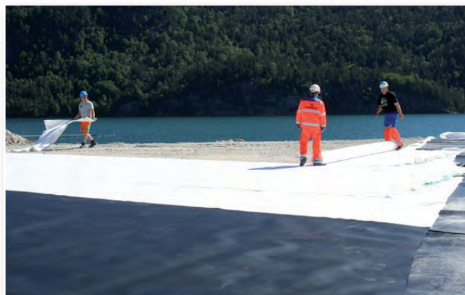
Plastmembran som bunntetting av avfallsdeponi
