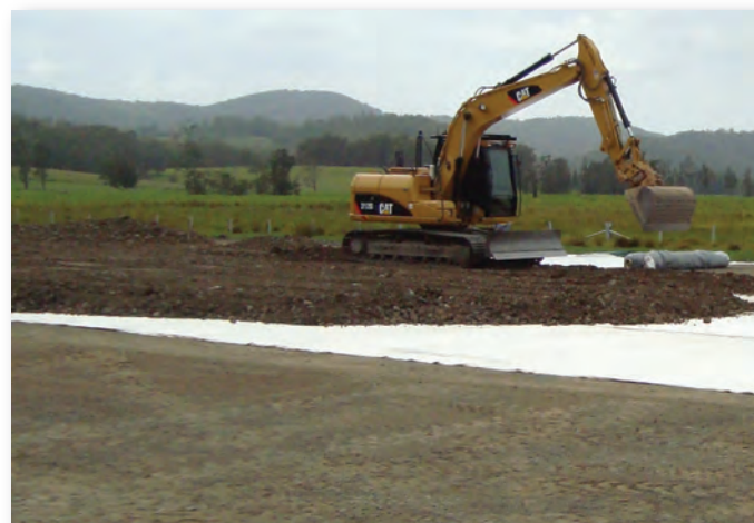
TeleVev® i bunn av forsterkningslag
