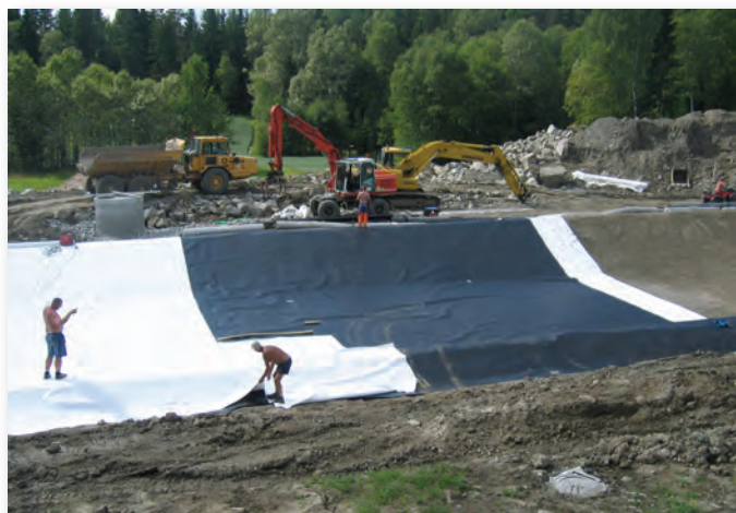
Fiberduk brukt som beskyttelse av membran i dam
