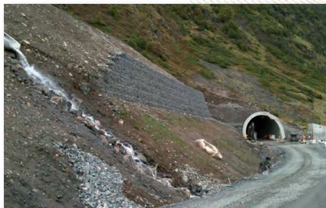
Gabioner i rasvull og rundt tunnelportal
