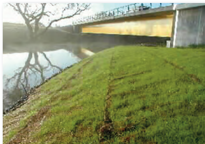
Erosjonssikring med komposittmatte
