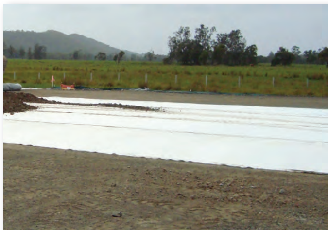
Fiberduk som separasjon
