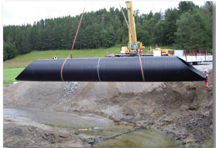
Weholite som kulvert/bro på Rv.3 Tynset
