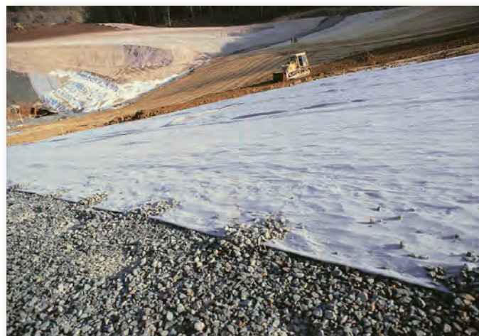
Fiberduk som separasjon
