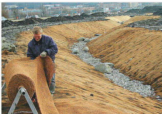
Erosjonssikring med kokosnett
